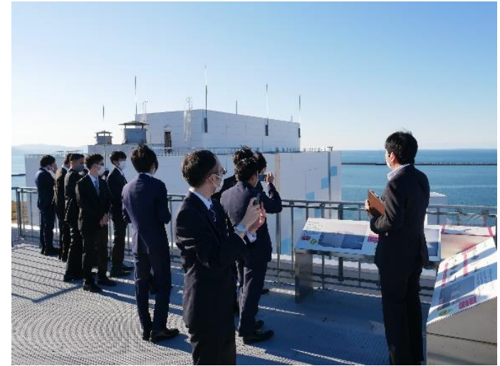
北海道電力(株)石狩湾新港発電所
