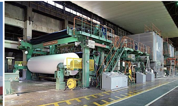
主要設備（1号マシン）
