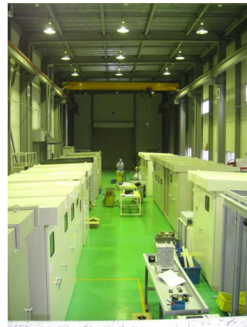
出荷を待つ配電盤・制御盤
