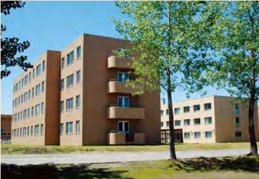
明誠寮 Meisei Dormitory
