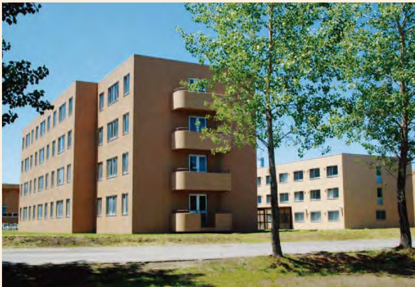
明誠寮 Meisei Dormitory
