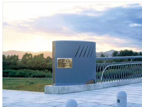
親柱・高欄（花咲大橋）
